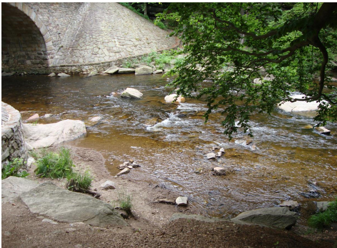
Obrázek 48 Most z roku 1903. postavený z pískovce italskými a českými kameníky a obnovený v roce 2005, se klene ve výšce 15 m nad Divokou Orlicí v prostoru Zemské brány v Orlických horách nedaleko osady Čihák. Foto: J. Štyrský
