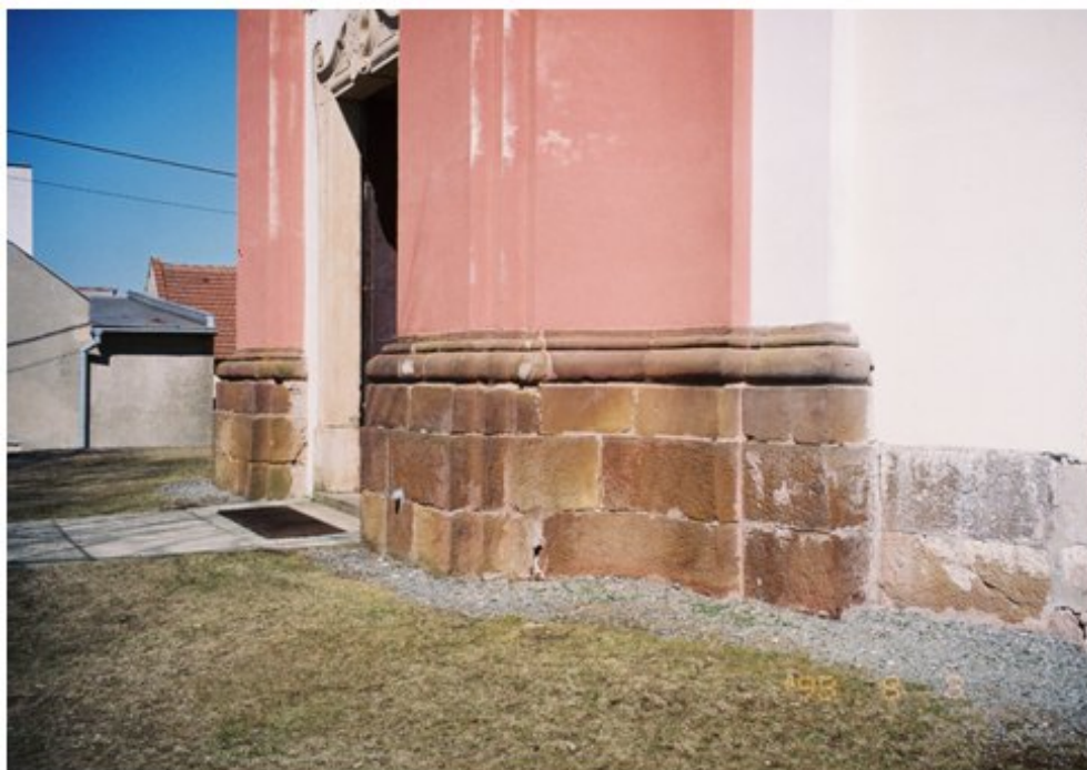
Kostel sv. Jana Křtitele - použití permských pískovců na stavební kvádry
