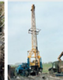
↓ Hloubení výzkumného vrtu o hloubce 400 m u Běchar na Jičínku.
