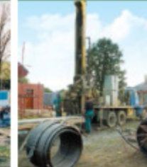
↑ Hloubení vrtu pro tepelné čerpadlo u rodinného domu ve Spoju u Pardubic.
