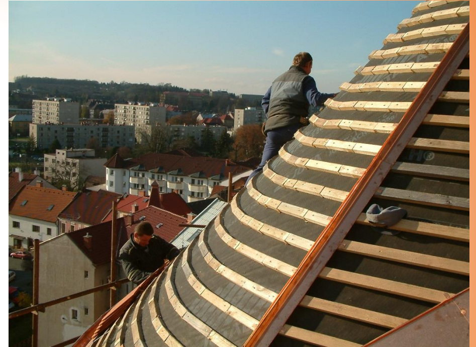
tašky a beton
