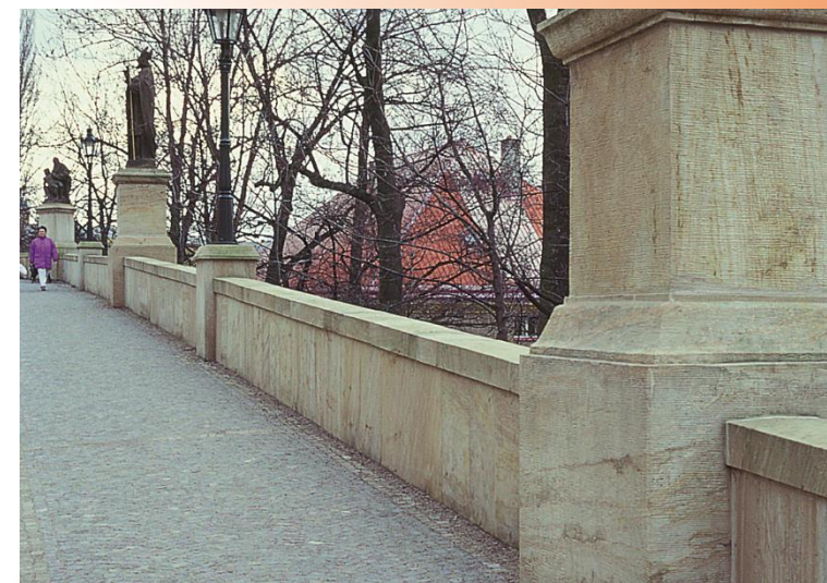
Nové „zábradlí“ pískovec z hořického hřbetu od Boháňky-Skály
